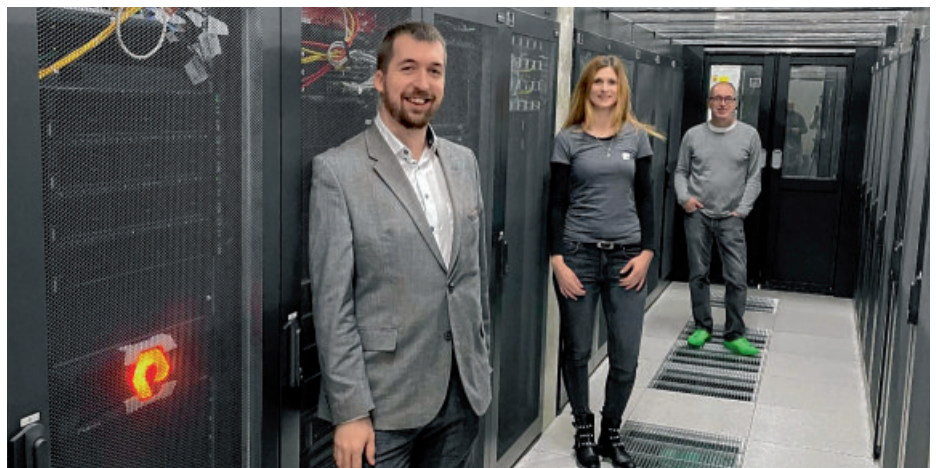
Dr. Benjamin Kastl (TriOptoTec GmbH/DYPHOX), Diana Boskovic (MD Coating) und Matthias Blatz (Heidelberg iT Management GmbH & Co. KG, v.l.) im Rechenzentrum „Serverhotel 2“ des Cloud- und Rechenzentrumsanbieters Heidelberg iT. Bild: Heidelberg iT
