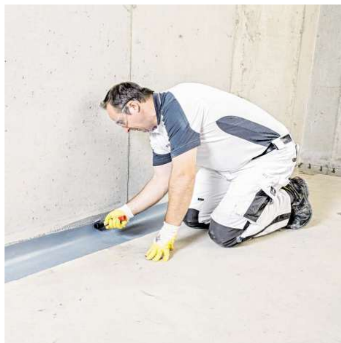
Mit Flexband haben Risse keine Chance.
