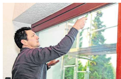
Ein Glastausch ist schneller, sauberer, leiser und kostengünstiger als ein herkömmlicher Fenstertausch und reduziert die Belastung für Bewohner und Nachbarn auf ein Minimum. BILD: DJD/CLIMAPLUSSECURIT-PARTNER/ANDRE BOECK
