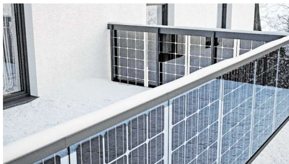
Auch die Balkonbrüstung oder Teile der Hausfassade lassen sich mit Solarmodulen versehen.
