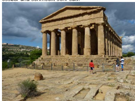
Im Tal der Tempel von Agrigento. Hier begegnen dem Besucher auf Schritt und Tritt geschichtsträchtige Bauwerke großer Baumeister.
